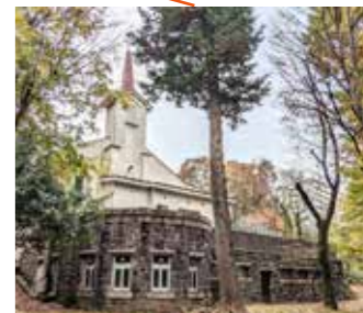
陸軍将校会議室跡（戸山幼稚園） 陸軍戸山学校の将校が会議を行った場所。現在は市立戸山教会幼稚園の園舎として利用されている。箱根山の南側に遺っている。
