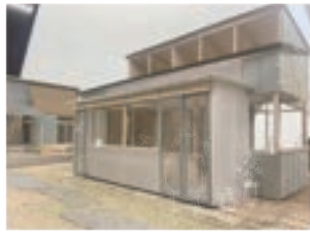
路地と一体的に利用される下層空間
