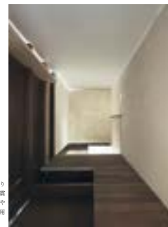
② 増築された壁と手すり が同じ。床を減築し耐震 補強することで、廊下や 収納スペースとして利用 される。
