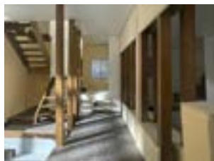
⑦ 壁の減築により、廊下として機能が変換
