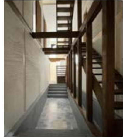
④ 新しい壁と既存の壁の二重構造
