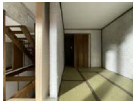
④ 新しい壁と既存の壁の二重構造
