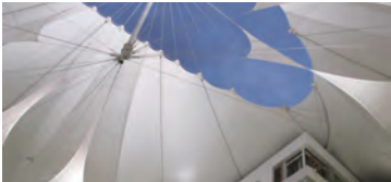
軽量の材料で構築できるテンション膜構造
