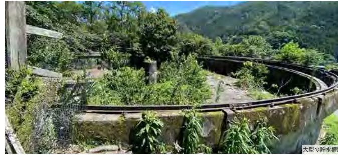
大型の貯水槽跡
