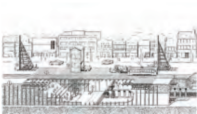
開削工法 (日比谷線建設史より)
