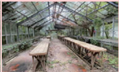
外気舎に隣接する放棄された温室
