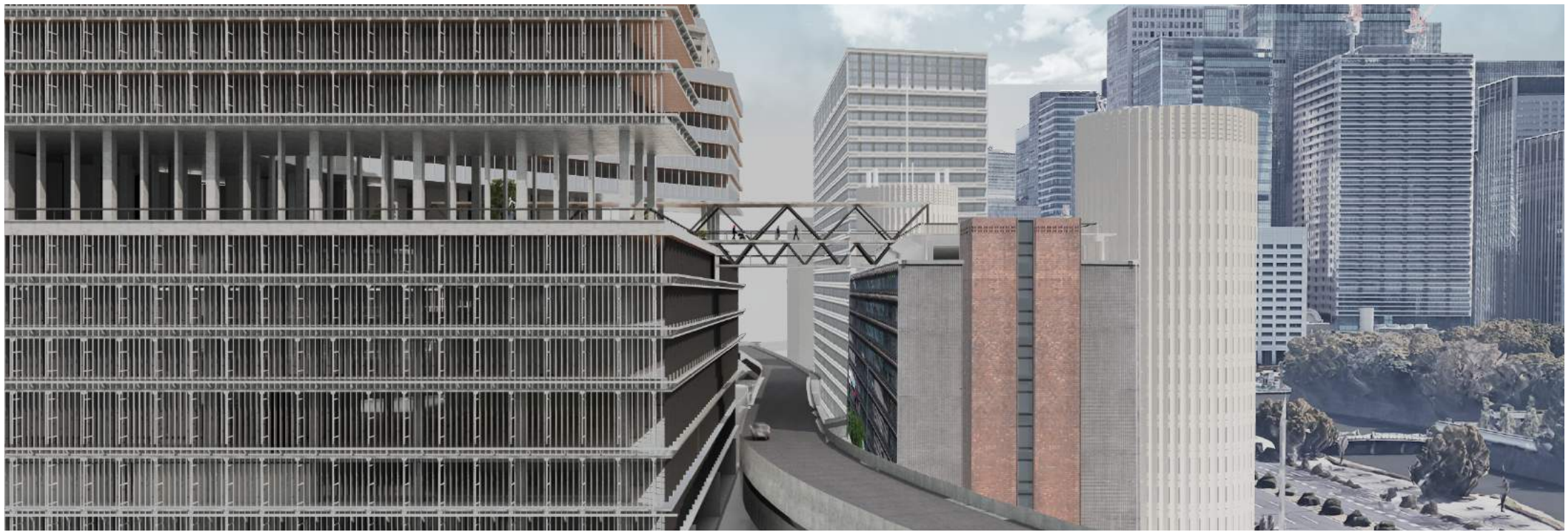
首都高速道路の上空には新旧2棟を繋げるブリッジが架かる
