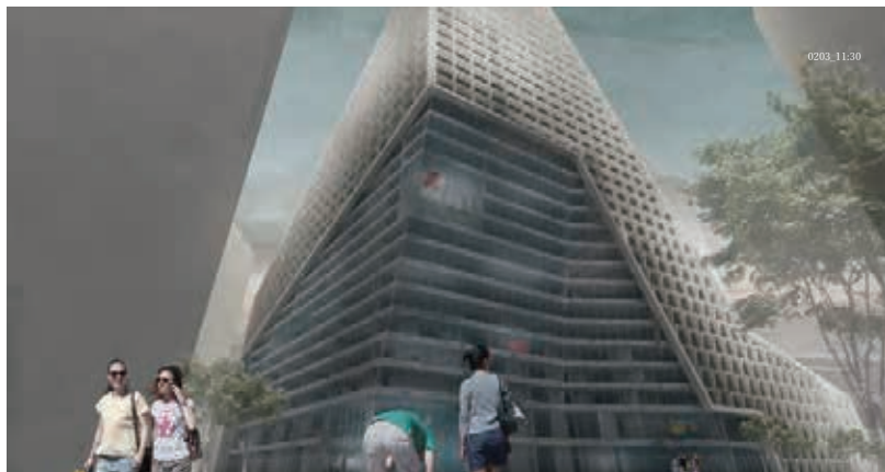
〈南西側道路からの見上げ〉 カーテンウォールは通常は太陽光を反射し内部が見えないが、影を取り込むことで内部が見え、道路からギャラリーが見える。
