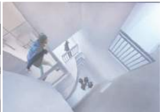
▲2階からの階段を見下ろす
