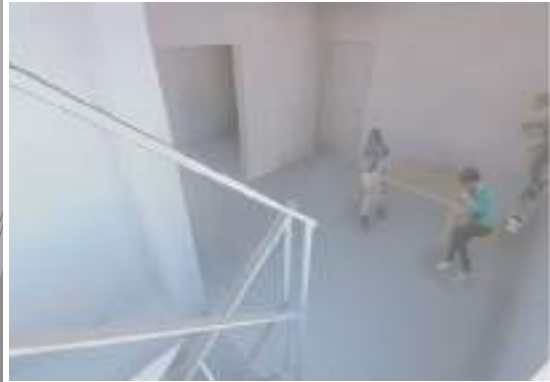
▲階段室から共用廊を見下ろす
