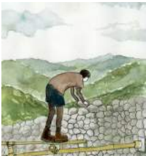
石を敷く。高くすると、竹をの壁に差し込み、足場とする。
