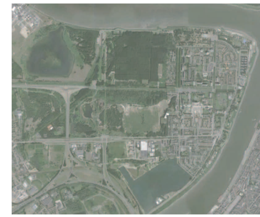
現在のアントワープ市区航空写真
