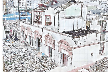
取り壊されている石庫門団地
