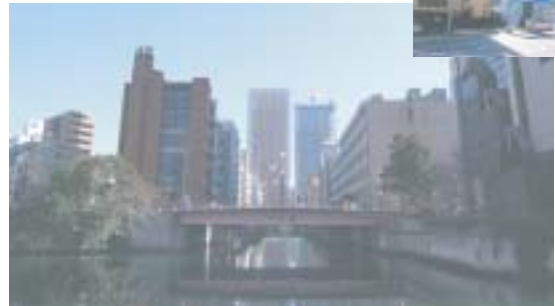
敷地1: 百代橋橋詰め
