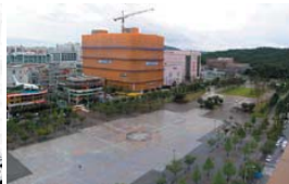
図12 敷地俯瞰写真
