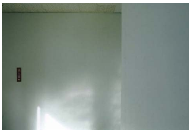
筑波大学体芸中央棟廊下 2
