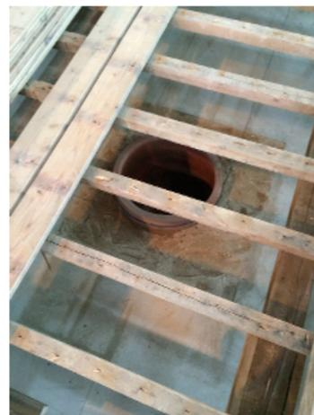
道場の床については、歴代の門下生のそれぞれの記憶や思いが染み込んでいる。また、道場にとって床組の柔剛の具合や踏み込んだときの響きと床板の足裏への感触は、非常に重要である。そこで、独特な床の組み方を既存の材を使って慎重に再建築した。既存の長さ五間（9m）厚さ一寸二分（36mm）の杉床板を既存の順番通りに敷き込み、必要最小限の補修を施した。床の響きのために埋められたと伝わる床下の瓶も同様に位置・深さ・傾きまで忠実に復元再埋設した。
