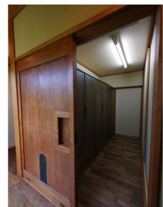
↑解体した蔵の引戸を再利用した収納入口。家具の出し入れの際に使用する。
