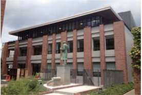
チャペル会館 新築 事務室・音楽ホール他 2013年7月
