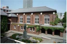
諸聖徒礼拝堂 防音改修・照明改修 礼拝堂 2013年7月
