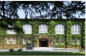
図書館旧館 内装改修 図書館旧館 → 学院史展示館 2014年5月
