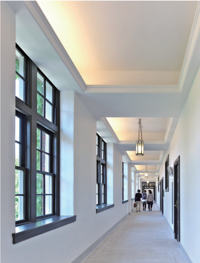
梁型を活かした折上天井とキャンパス内モチーフを参照して特注製作したペンダント照明を設置した廊下。耐震補強が施されたことを感じさせない空間デザインとした。
