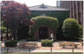
3号館 内装改修 研究室 → 入学センター他 2013年9月
