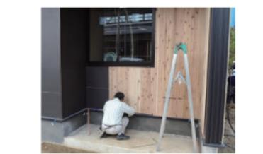
外壁施工写真：外壁の木質化は下地に「石こうボード+鉄板」を張ることで可能としている。
