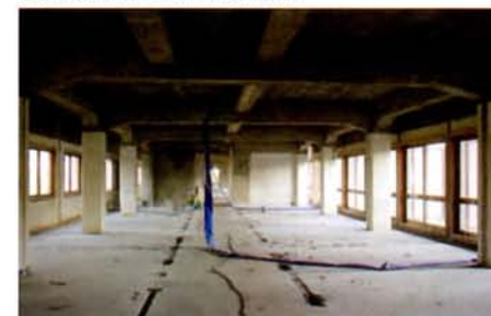
50年が経過し一度躯体の状態にまで戻して改修
