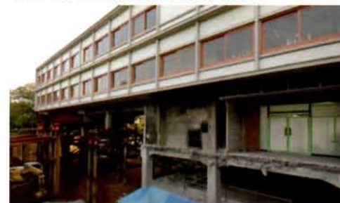
必要な機能（ホール）を地下に増築した工事の状況
