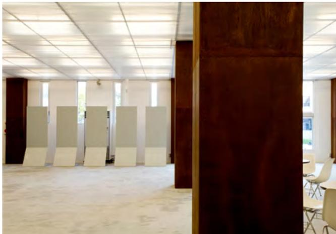
ホール内部：コンクリートの床、鉄の柱、塩ビ波板の天井
