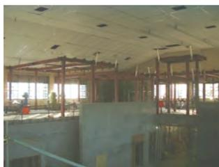
工事中：RC造の箱の上のS造建方
