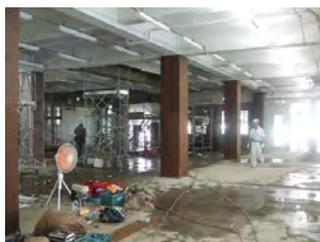
解体中：雑壁の撤去、同時に柱の鉄板巻
