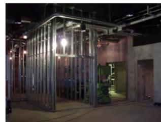
工事中：RC造の箱内部の間仕切り
