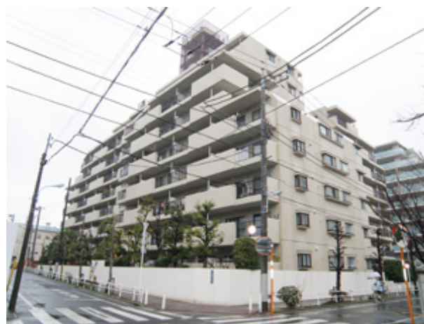
建物外観(施工前)
