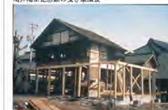
高山滝山記念館は三度にわたり曳き家し、改修した
