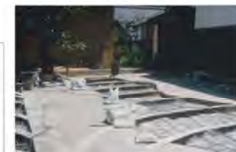
風の広場・コンクリート吹き出しによる風紋のデザイン
