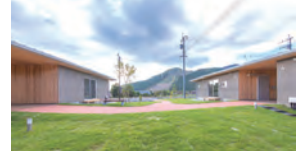
熊本地震: 南阿蘇災害公営住宅長陽西部団地
