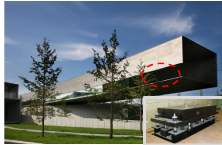
片持ち構造体の制振事例
