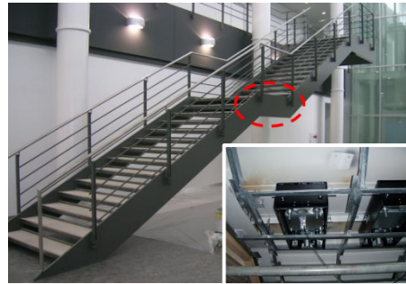
鉄骨階段の制振事例
