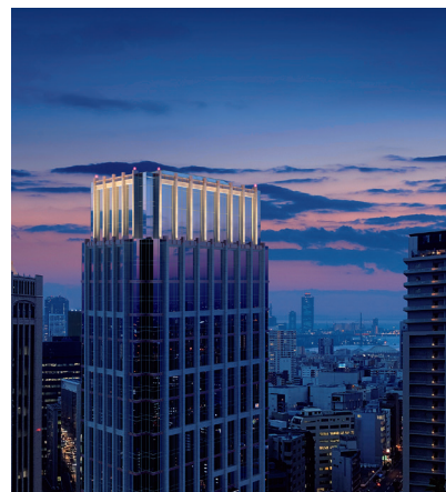
屋外照明「ZEROシリーズ」施工例
