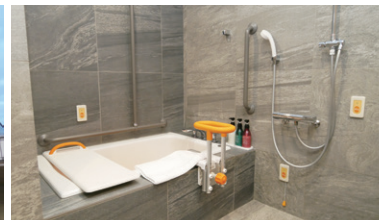
▲脱着式備品を設置したバスルーム
