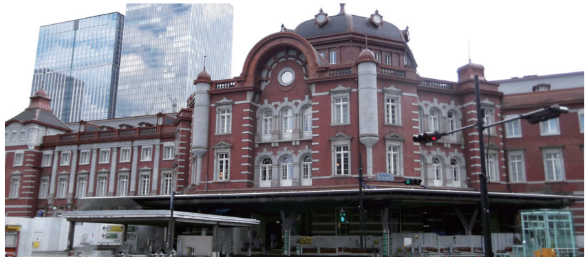
東京駅丸の内駅舎の地下外壁の壁面などにも防水材「BIG SUN」が使われています
