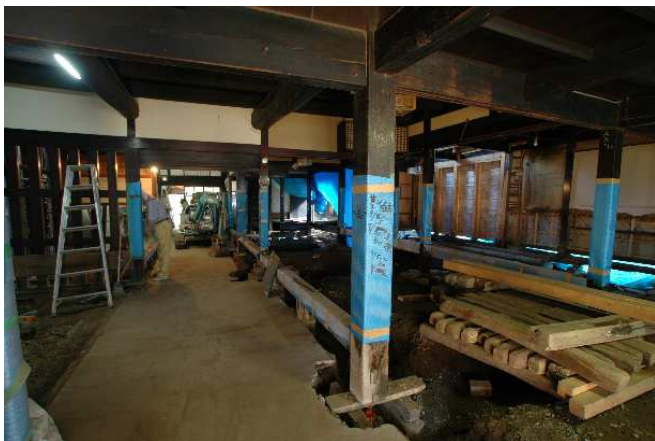
築 250 年の古民家改修現場（岐阜県）
