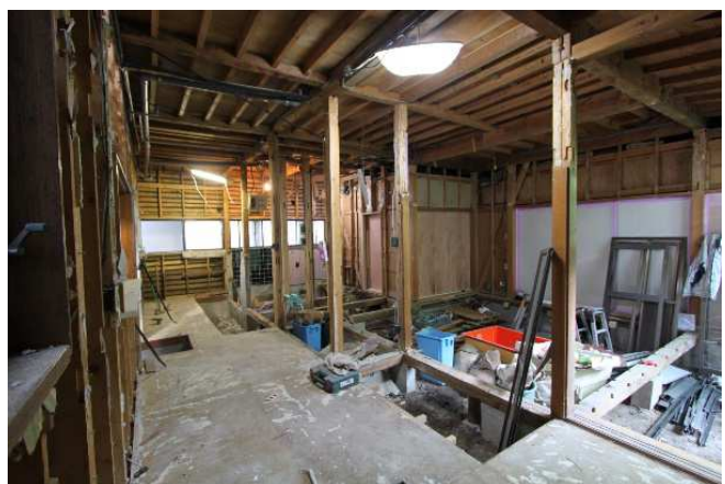
築 40 年の民家改修現場（東京都）
