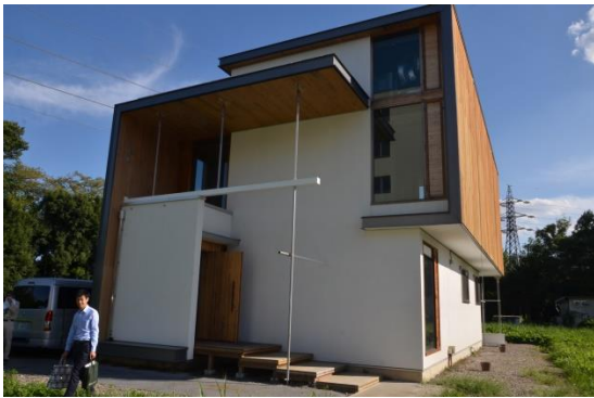
「つくばCLT実験棟」
