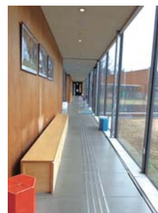
点字ブロックが中央に配置された廊下
