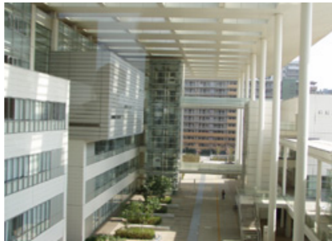
教育研究棟と管理厚生施設棟の建物群 中央に配置された交流広場
