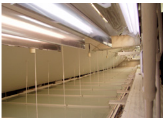
展示室トップライト天井内部 反射した間接光が室内に届く
