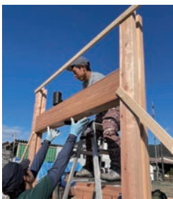
写真5 木材を上から落とし込む
