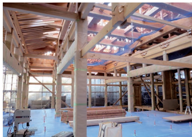
珠明寺本堂：建物の架構
