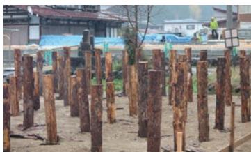
写真4 松杭による地盤改良
