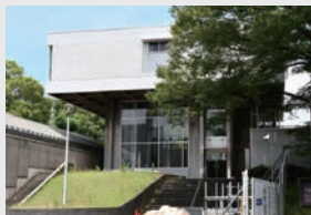
解体工事前の聖賢堂
