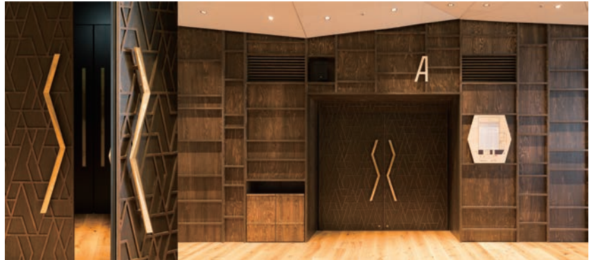
真鍮鑄物のカスタムハンドルの事例。設計士の想いを形にし、経年美化を愉しむ
