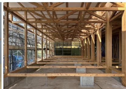
進行中の「戸塚のオフィス」。300角の柱で水平力に対応する架構
