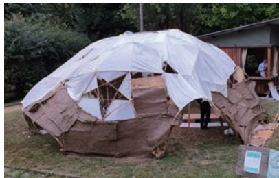
完成間近のドーム
