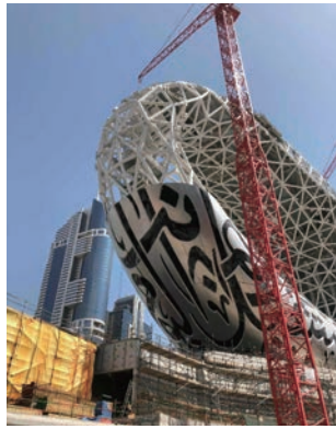
未来博物館、建設中の様子
