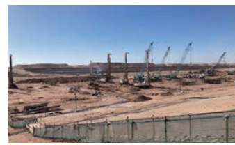
直線高層都市 THE LINE の建築現場
