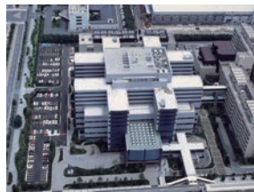
横浜市立大学付属病院(1991年竣工)
