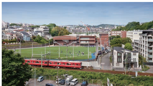
改修後の外観
