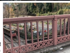
千登世橋と都電荒川線 (豊島区目白)
