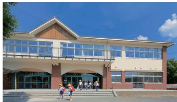
横瀬小学校 この春に1期工事を終え、現在2期工事が進む
