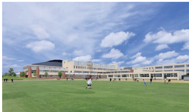
大崎学園 増築した新校舎(左)と既存小学校校舎(右)
