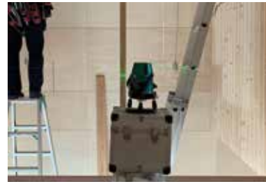
レーザーを使ってペンダントライトを設置 (大和工務店)
