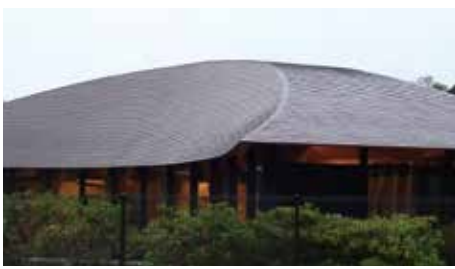
「梅郷礼拝堂」(設計：加藤建築設計事務所、板金：新井建築板金)
