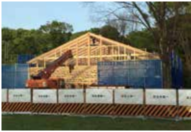
「まちのこども園代々木公園」上棟風景 (設計：ブルースタジオ、施工：大和工務店)
