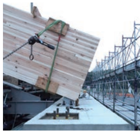
コンクリートの土台に木架構を載せる ©MOUNT FUJI ARCHITECTS STUDIO
