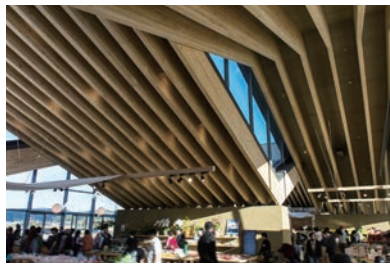
山型の木架構で柱のない大空間をつくる
