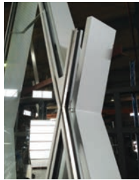
「MISS HIROSHIMA (Tamaya BLD)」 (設計：FUTURE STUDIO) 構造はフラットバー（鉄のプレート）を使いダイヤモンド形状で構成し、そこにガラス外装をミニマムにデザイン。構造エンジニアとファサードエンジニアの協働。 右はモックアップ。
