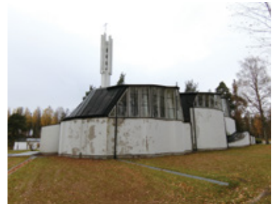
2017年フィンランドの旅で撮影した教会 (撮影: 彦根アンドレア)
