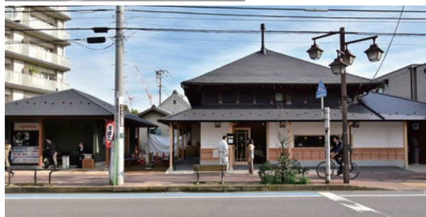
【改修後】明治期の建物をリノベーションした建物(右)、新たに新設した煙草店(左)。分棟形式に建物を整理し、それぞれの隙間を軒下空間で連続させ緑のある路地を敷地内に引き込んだ。
