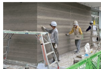
版築風仕上げの施工風景
