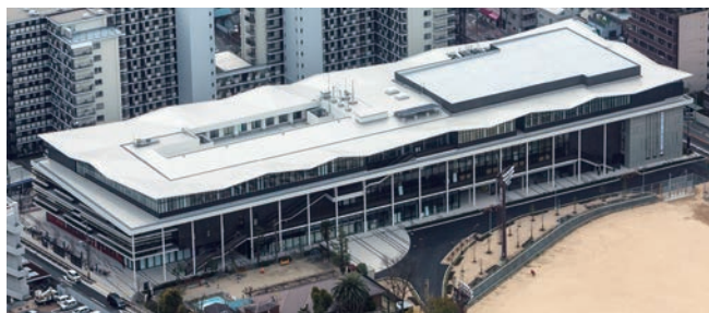
「AXSP」 複合施設屋上施工
