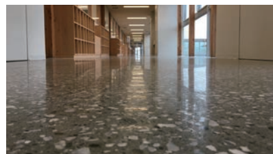
「クリスタルハード」 学校廊下施工
