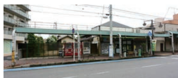
【改修前】 老朽化したアーケードに隠れていた外観。商店街の活気が年々薄れていた。隣地は高層マンションに建て替わっている。
