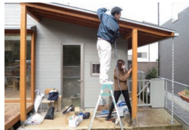
鎖樋「ensui」の試作品を実地検証
