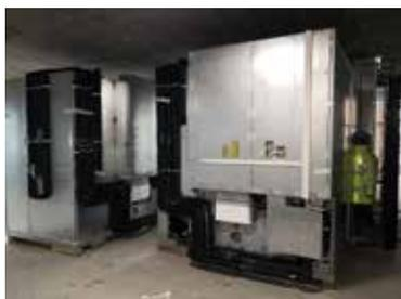
部品化・量産化されたサブシステムとしてRC躯体に運び込まれた設備コア
