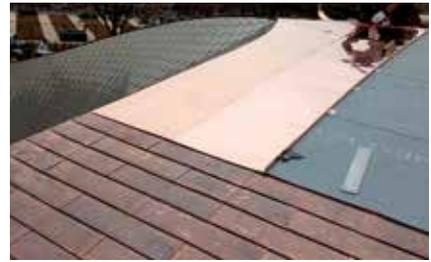
防水用巻きハゼ大板施工中の様子。この上に吊子をハンダ付け平葺き
