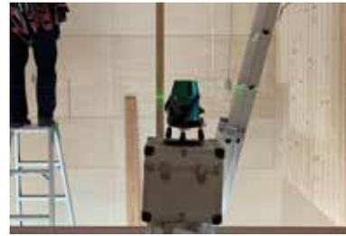
レーザーを使ってペンダントライトを設置
