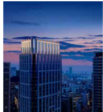
屋外照明「ZEROシリーズ」施工例
