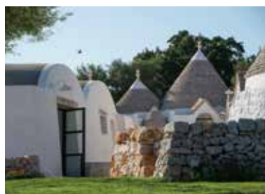
再生されたボルゴ・カノニカ
