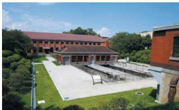
旧三河島污水処分場唧筒場施設(東京都下水道局 ホームページより)
