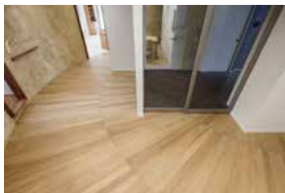
フローリングを放射状に施工したクリニックの事例（設計：DOG一級建築士事務所 写真：中山保寛）
