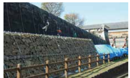
石垣修復工事の様子
