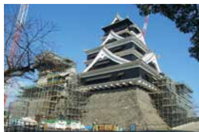
石垣修復中の熊本城天守閣
