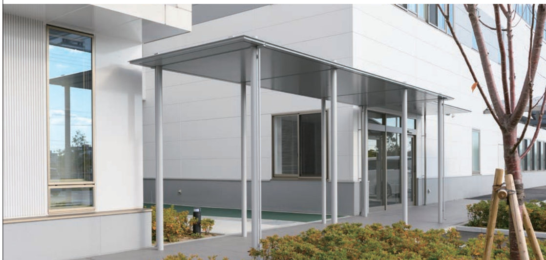
シェード 港湾技能研修センター(神戸) (兵庫県) 設計: 梓設計
