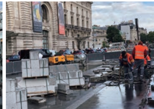
道路の補修工事の作業中
