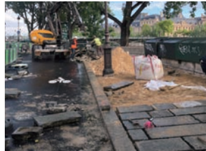
作業を終えた箇所とこれから箇所
