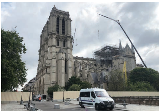
工事関係者以外は立ち入りできないようになっていた
