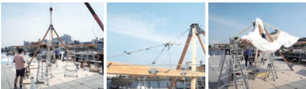
ノマディック・ルーフ施工の様子
