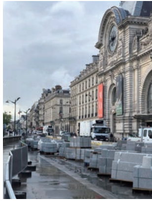
道路の工事箇所は柵で囲われている
