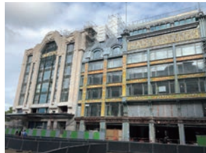
内部がほぼスケルトン状態の改修現場
