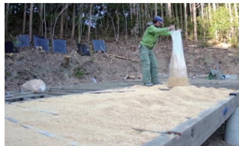
エコハウス床下に籾殻を敷き込む。後ろにはソーラーパネルが見える。
